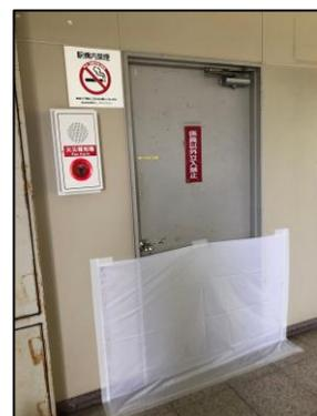
電気室入口に浸水防水シート設置状況
