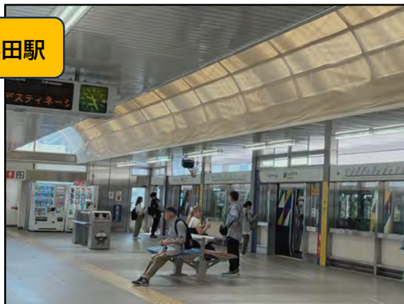
遮熱シート施工後
