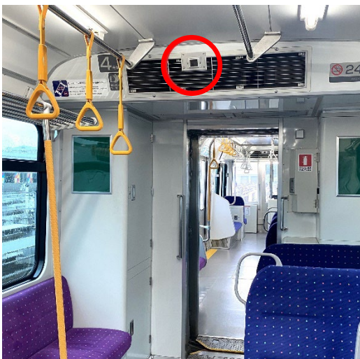
↑ 車内に設置されている防犯カメラ （赤印の箇所に設置）
